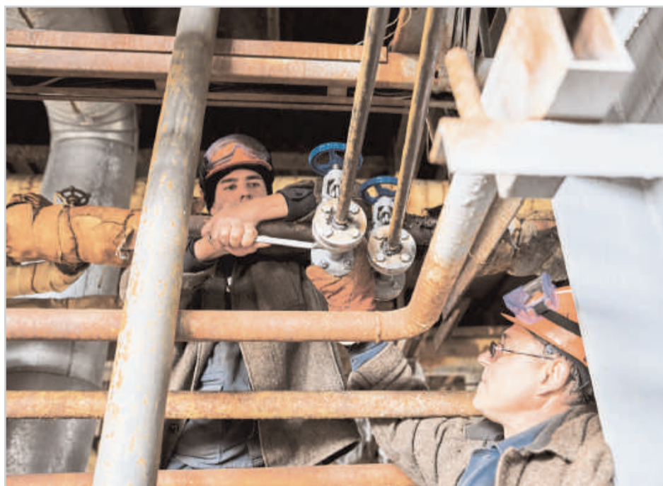
Слесари-ремонтники М. Лукин и В. Леоненко производят замену коренных арматур на теплоспутниках (трубопровод обогрева) технологической установки.
