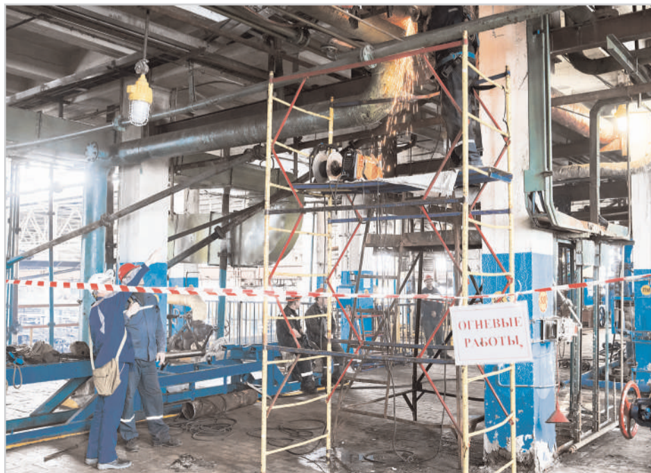
Ремонт трубопровода рассола в цехе Е-1-9-12а выполняют специалисты цеха РТО ООО "Химремонт".
