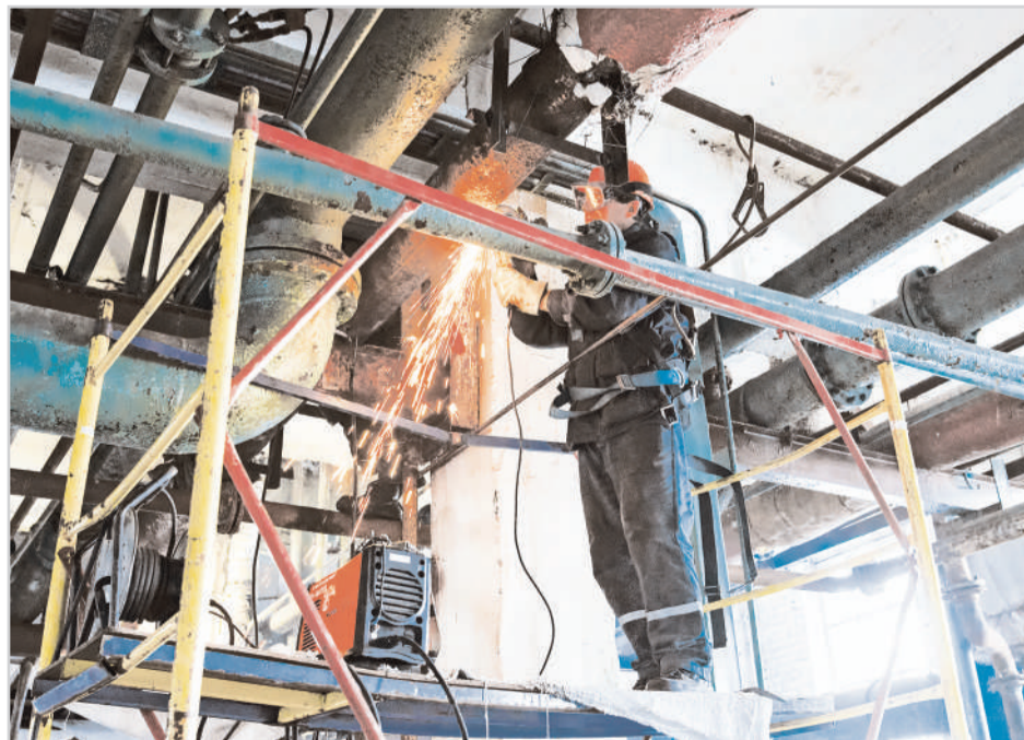
Ремонт трубопровода рассола в цехе Е-1-9-12а выполняют специалисты цеха РТО ООО "Химремонт".
