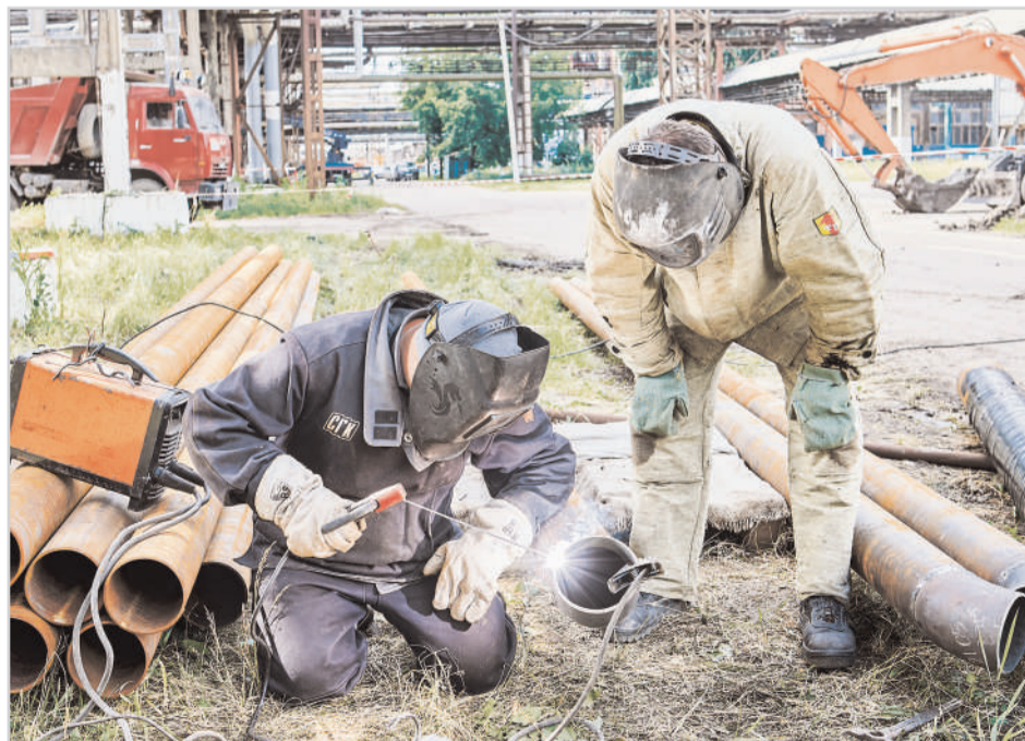
На трубопроводе промышленной воды с южной стороны цеха И-7-10 специалисты подрядной организации делают заготовки для последующего монтажа.
