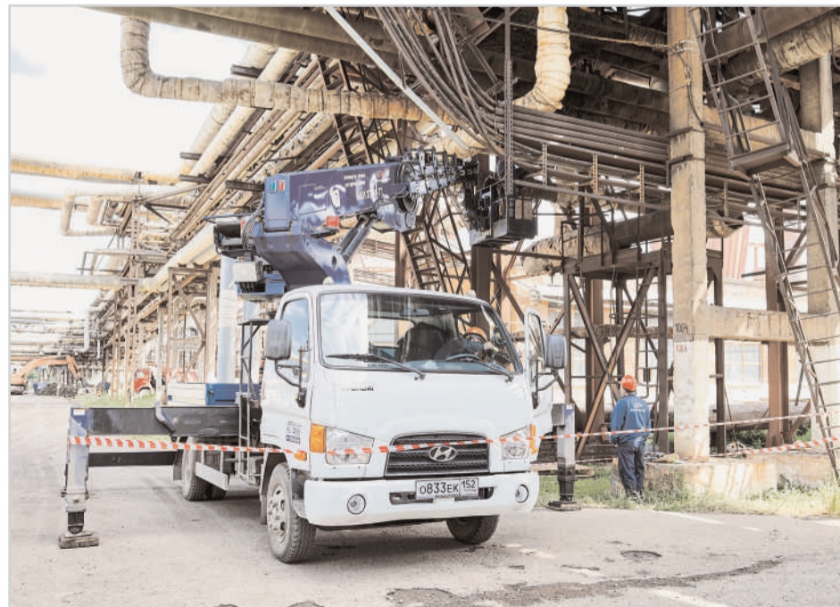
На трубопроводе Ду 250 мм цеха И-7-10 производятся работы по демонтажу и монтажу задвижки. Задействована спецтехника и специалисты подрядной организации.
