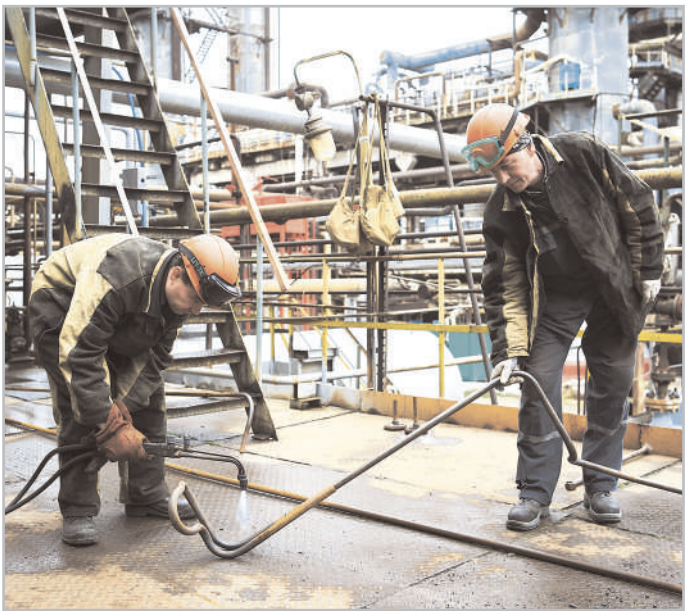
Газорезчик цеха РТО ООО "Химремонт" Олег Максимов (из бригады мастера Александра Аксенова) производит ремонт теплоспутников для обогрева линии водорода.
