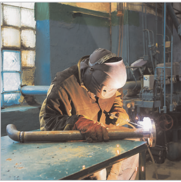
Бригада мастера цеха РТО ООО "Химремонт" Ульфата Гилязетдинова производит замену трубопровода отопления в бытовом помещении отд. №2 цеха И-11. На фото - сварщик Роберт Валеев.
