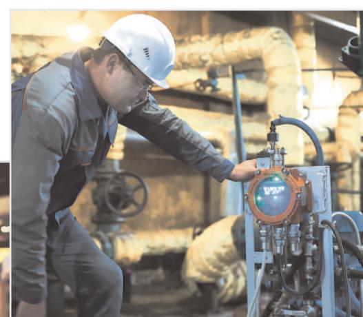
Для отмеривания антиагломератора Квантислип был установлен электронный дозировочный насос.
