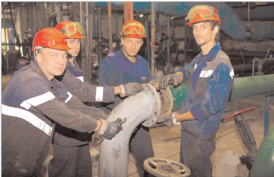
В цехе Е-2 проводится замена дефектного участка трубопровода латекса.
