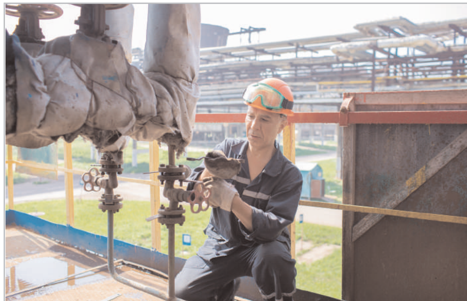
Процесс разглушения емк. поз. 108/2 в цехе Д-4-8-10.
