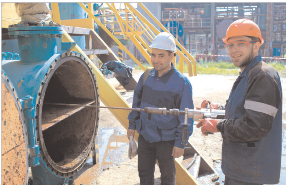
В цехе Д-4-8-10 проводится сверловка холодильного агрегата.
