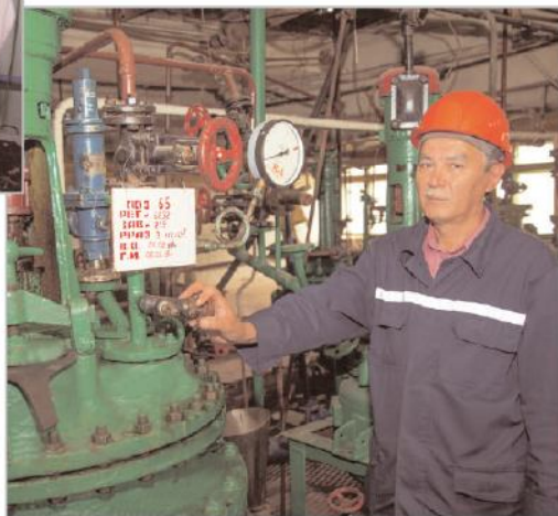
На опытной установке ЦЗЛ - слесарь-ремонтник Марат Ишбаев
